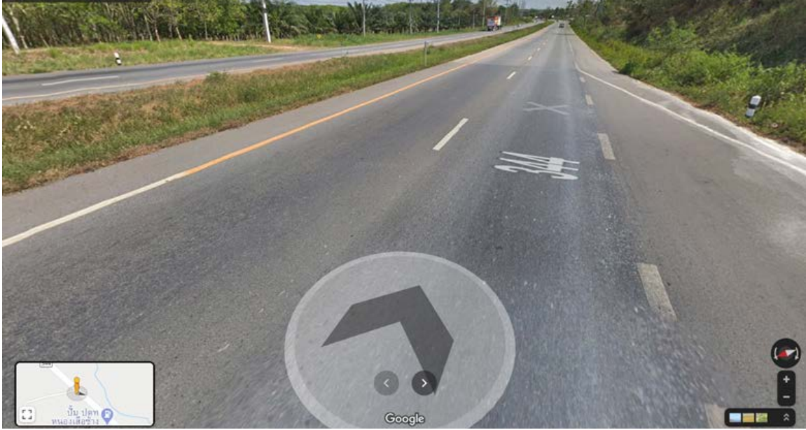
ภาพที่ 3.5 รูปภายหลังการบูรณะทางหลวงหมายเลข 344 ตอน อ.บ้านบึง – อ.แกลง (RT) บริเวณจุดแบ่งพื้นที่ก่อสร้าง ตอน 1-1 และ ตอน1-2 (ภาพจาก Google Streetview, 2562)
