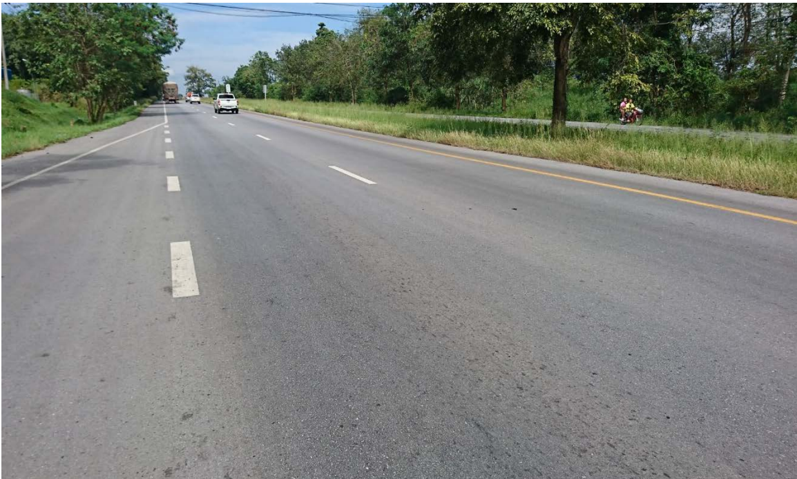
ภาพที่ 3.4 รูปภายหลังการบูรณะทางหลวงหมายเลข 344 ตอน อ.บ้านบึง – อ.แกลง กม. 56+ 000 RT
